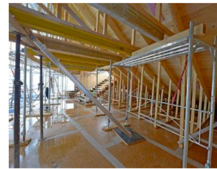
Ein Blick unter die Halfpipe zeigt die aufwendige Konstruktion der Anlage. Im Hintergrund ist eine der Treppen zu erkennen, die auf die Bühne führen.
