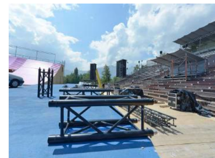
Noch gibts was zu tun: Bis zur Premiere müssen unter anderem noch die Scheinwerfer installiert und die Stühle montiert werden.
